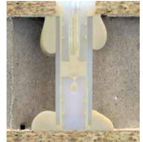
Certifique-se sempre de que há um espaço de 1-2 mm por baixo da cavilha para que a cola possa colar-se à camada de superfície inferior (folga máxima de 3 mm).
